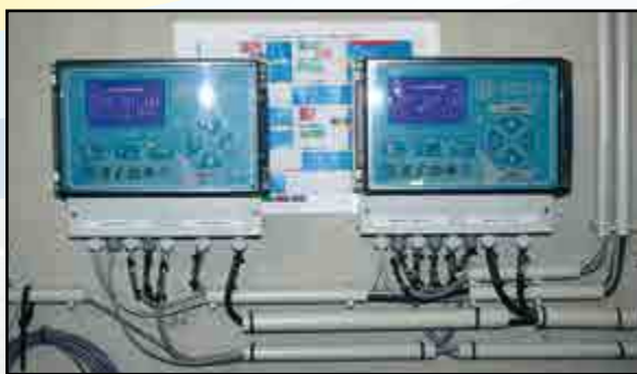
Matériel d'analyse de type Syclope permettant une surveillance constante des critères imposés par la réglementation.
