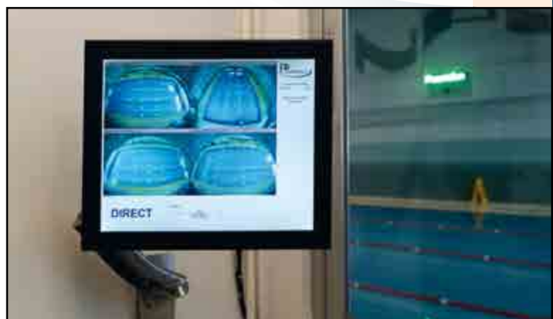
Détection noyades sur écran Poséidon caméra subaquatique
