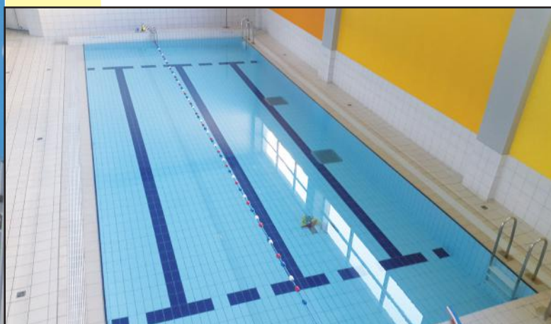
Exemple de plages aux dimensions insuffisantes pour permettre aux personnes se déplaçant en fauteuil d'accéder au petit bain. L'unique échelle permettant de rentrer dans l'eau est située dans la partie la plus profonde du bassin.
